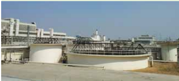
3600 m 3 /d effluent treatment
